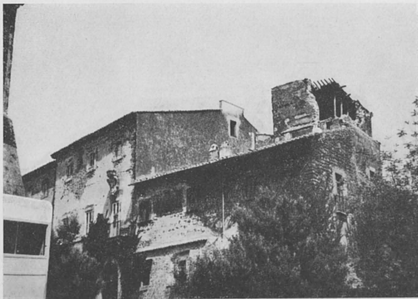
Fig. 2 - Facciata del castello di Rota. In alto, a destra, la torre in parte crollata per effetto del sisma. (Foto G. Cirilli)
