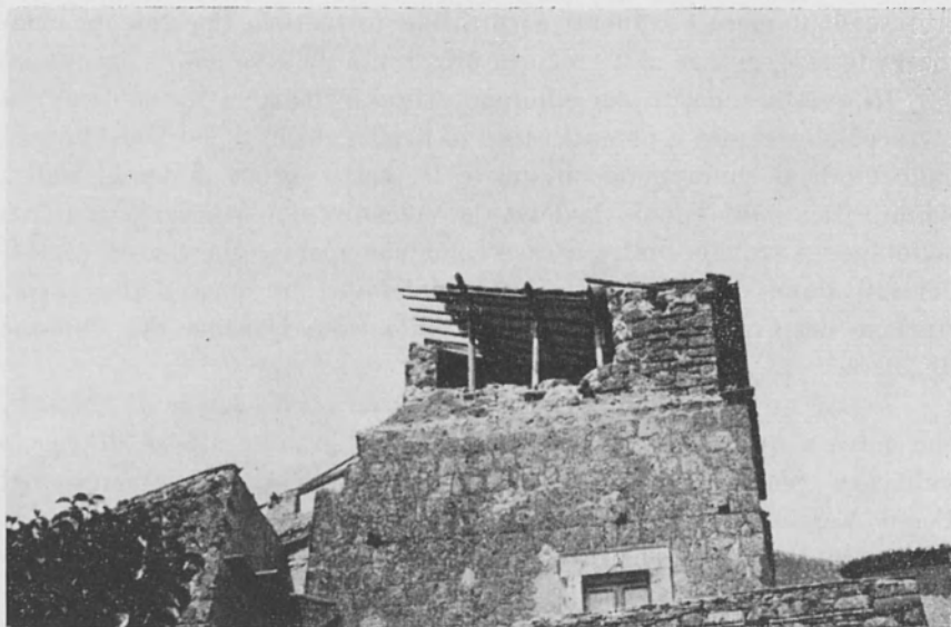
Fig. 3 - Veduta laterale della torre del castello di Rota. La parte inferiore, di costruzione trecentesca, è rimasta indenne; quella superiore, di costruzione posteriore, è crollata quasi totalmente. (Foto G. Cirilli)
